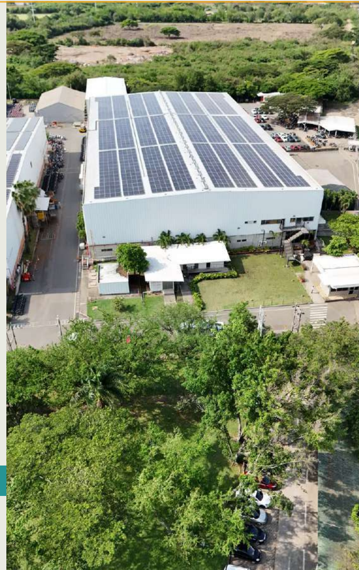
Sistema de generación fotovoltaica, planta Yumbo
